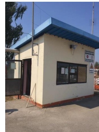
Zgrada br. 5 - Portirnica
