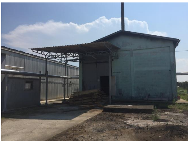
Zgrada br.6 - Kotlarnica
